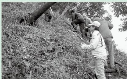
▲階段を修理して使いやすくなりました
